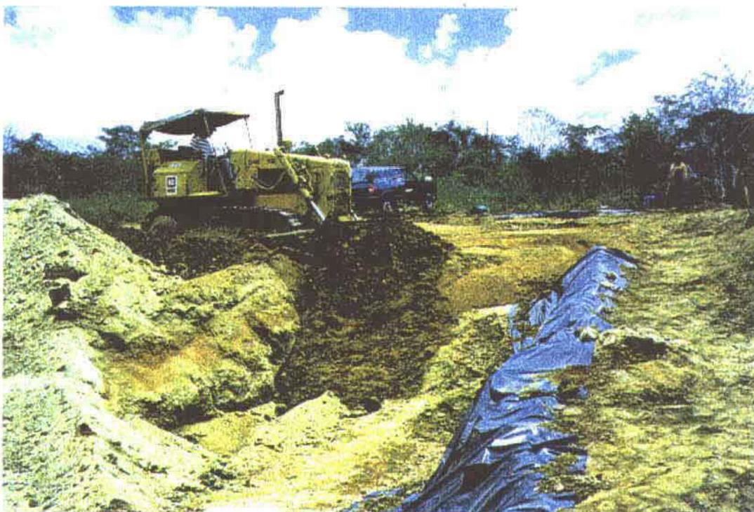
**Completada a impermeabilização da parede de jusante, é iniciado o preenchimento da trincheira com o próprio material dela retirado**
