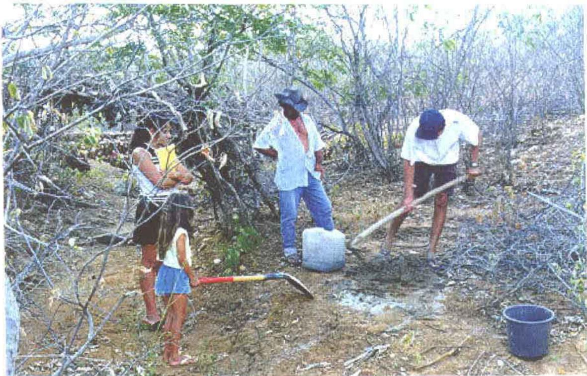
Figura 9: Preparação do concreto para fixação da régua.
