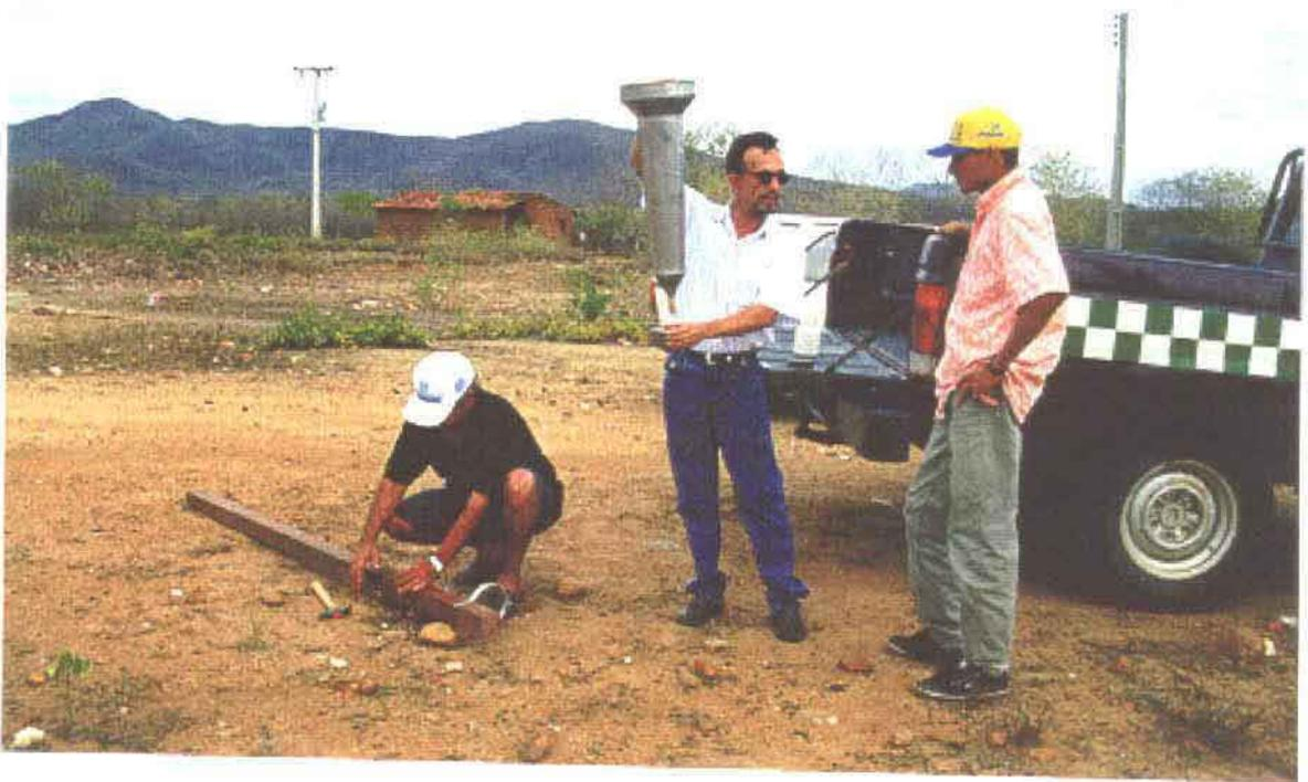
Figura 2: Equipe descarregando e preparando o material para montagem do pluviômetro.
