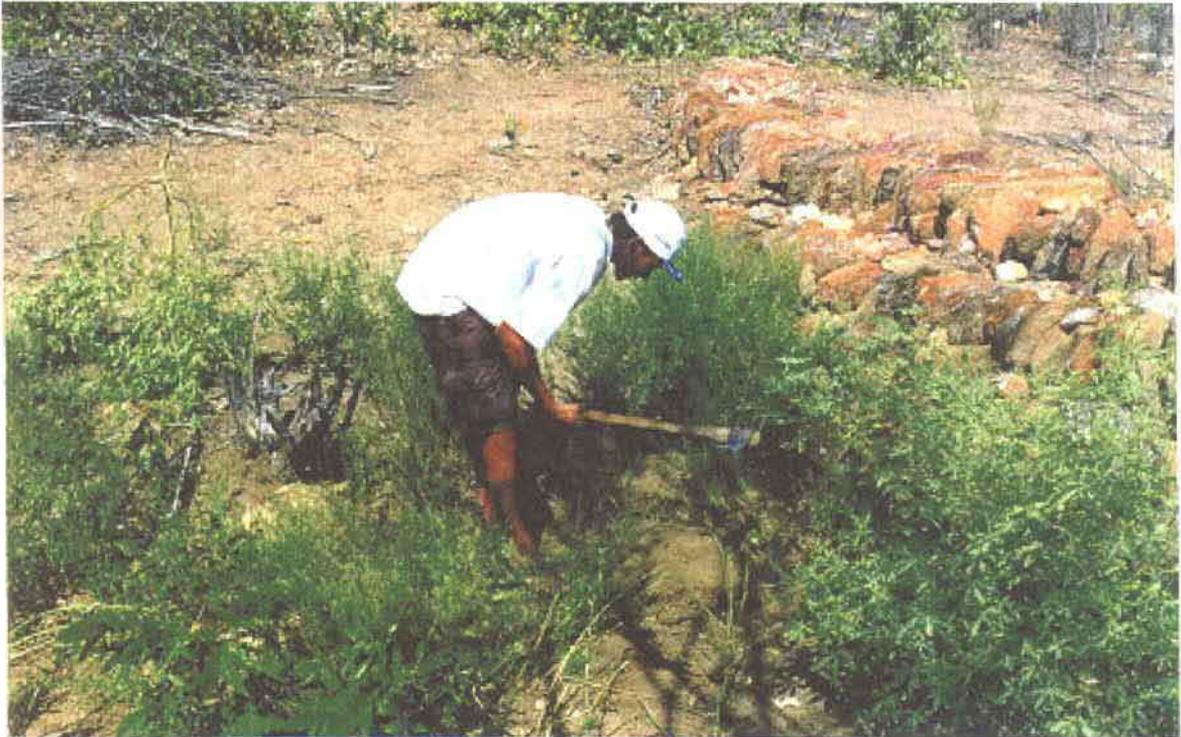
Figura 8: Perfuração do local de instalação da régua.
